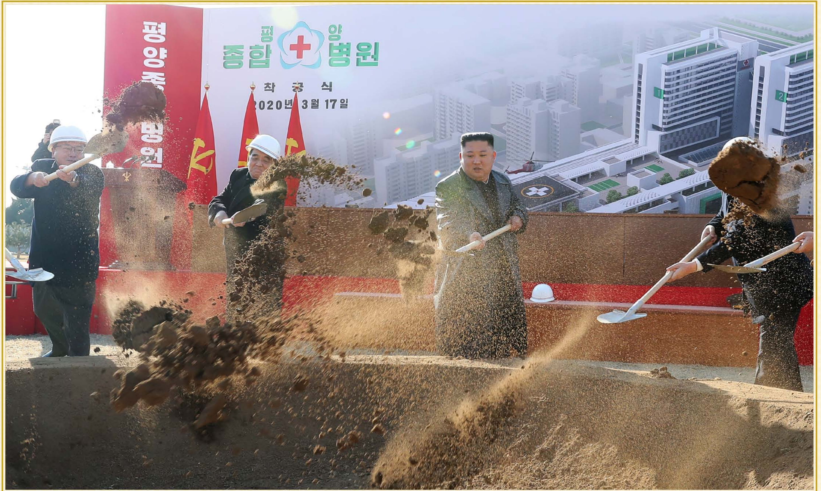
Kim Jong Un verkündet den Baubeginn für das Pyongyanger Krankenhaus vor Ort und macht den ersten Spatenstich. März 2020
