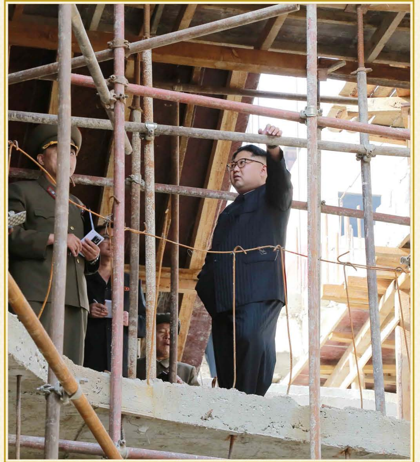
Kim Jong Un bei der Vor-Ort-Anleitung der Baustelle der Augenklinik Ryugyong, Mai 2016
