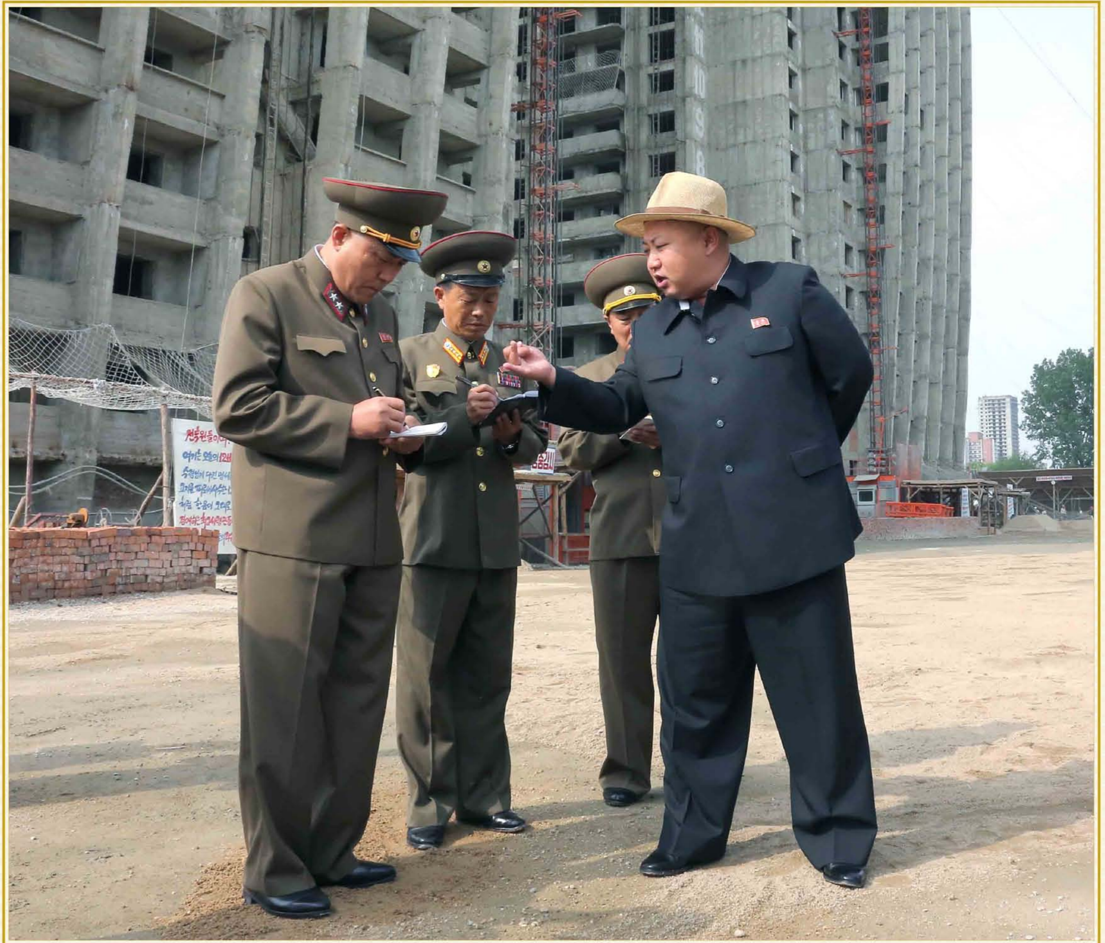
Kim Jong Un beim Rundgang durch die Baustelle der Wohnhäuser für Pädagogen der Technischen Universität „Kim Chaek“, Mai 2014
