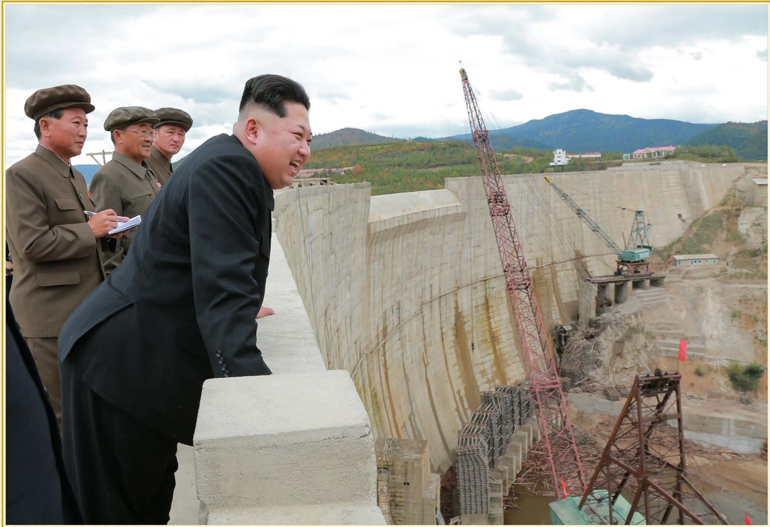
Kim Jong Un bei der Vor-Ort-Anleitung der Baustelle des vor Fertigstellung stehenden Paektusan-Kraftwerkes der Heroischen Jugend, September 2015
